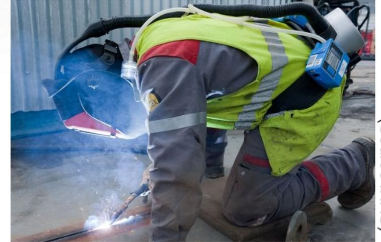
OPÉRATEUR ÉQUIPÉ D'UN SYSTÈME DE PRÉLÈVEMENT PENDANT DES OPÉRATIONS DE SOUDAGE
